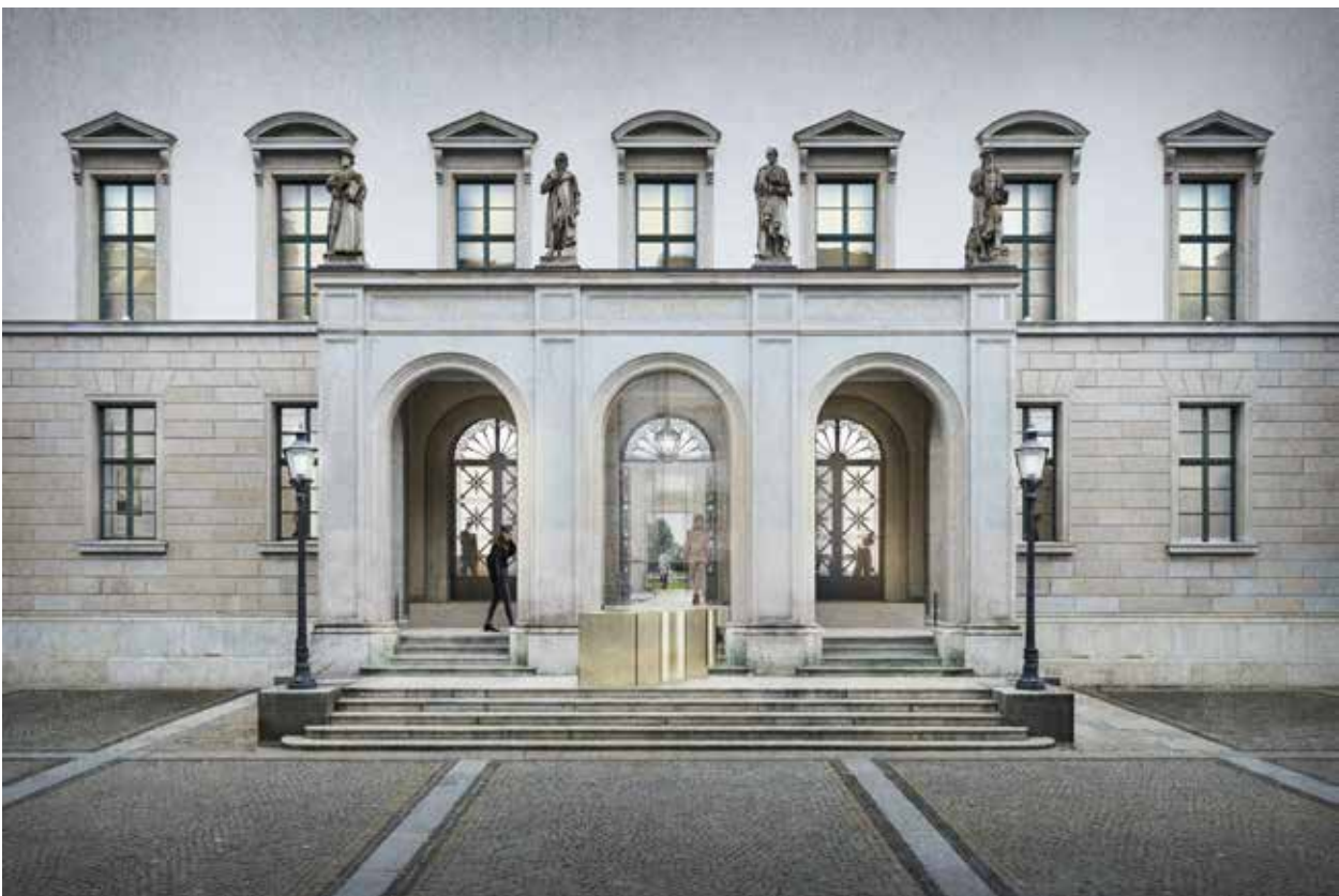
Eingang Seite Stadthausstrasse
